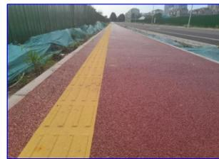
图 3 热熔盲道施工效果
